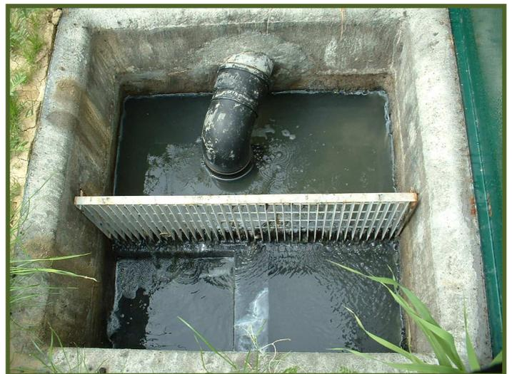
La vasca è ricavata scavando il terreno per una profondità media di circa 1,2 m, è interamente impermeabilizzata tramite una geomembrana in polietilene ad alta densità per evitare infiltrazioni del refluo trattato nel terreno e nella falda sottostante, ed è stata riempita con ghiaie di diverse granulometrie prescelte in base agli obiettivi depurativi e ai carichi idraulici previsti.
