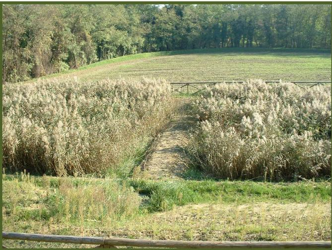
Un dispositivo posto a valle della vasca permette di mantenere costantemente il livello del refluo al di sotto della superficie, evitando in tal modo problemi di aerosols, cattivi odori e proliferazione di insetti nei pressi dell'impianto, posizionato a breve distanza da residenze abitative. Nella vasca sono piantumate essenze vegetali acquatiche autoctone (*Phragmites Australis*).
