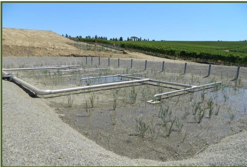
L'impianto di fitodepurazione è di per sé innovativo rispetto ad altri impianti di depurazione naturale per cantine, in quanto non prevede un trattamento primario: grazie all'inserimento di un sistema dalla francese (RBF) in testa non si hanno fanghi da smaltire: i fanghi in superficie vengono reimpiegati in agricoltura dopo circa 10-15 di funzionamento mentre le acque in uscita riutilizzate per l'irrigazione.
